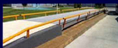
Instalación con rampas de acceso
