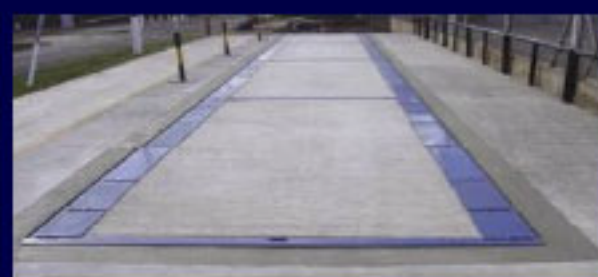
Instalación con rampas de acceso
